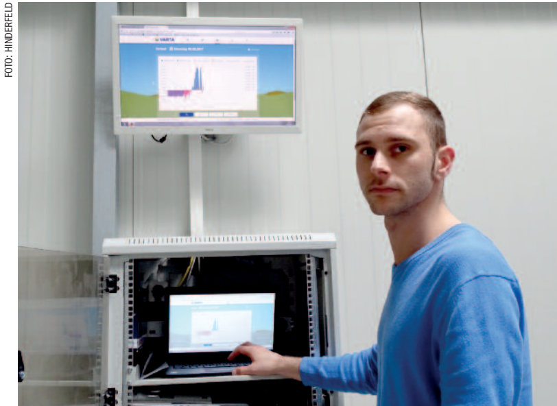
FOTO: HINDERFELD Energiescout Adriano Razzino kontrolliert bei B&S Service die Messwerte der Heizungsanlage.
