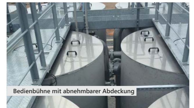
16 FlowSand-Filter für einen Vollstromkreislauf im Stahlwerk
