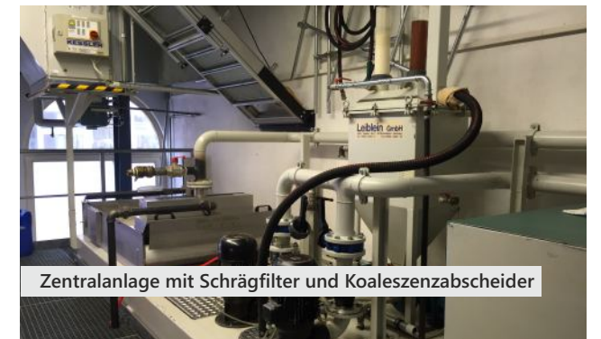
Reinigung von Emulsionen in der Kolbenfertigung
