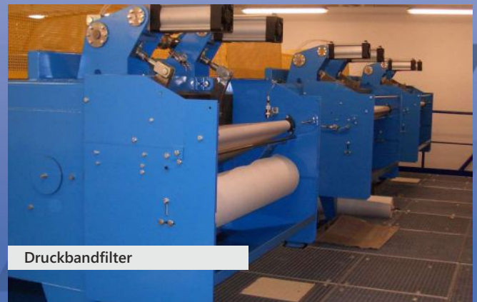
Montage eines Druckbandfilters
